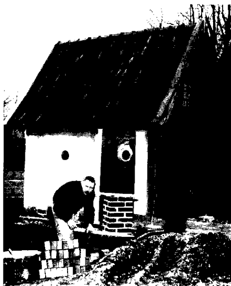
Josef Sieverding bei der Sanierung von Feldhüters Kapelle
