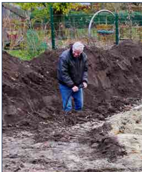
Lutz Bense beim Verlegen der Versorgungsleitungen für den historischen Bahnhof
