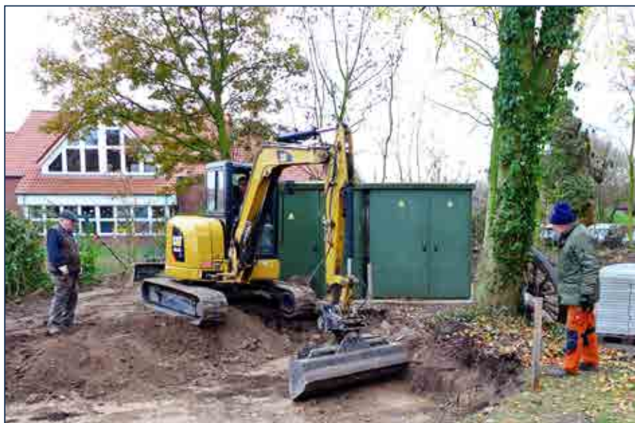
Schweres Gerät bei den Erdarbeiten im Pfarrgarten
