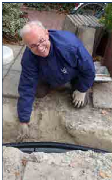
Richard Bothe beim Verlegen von Leitungen
