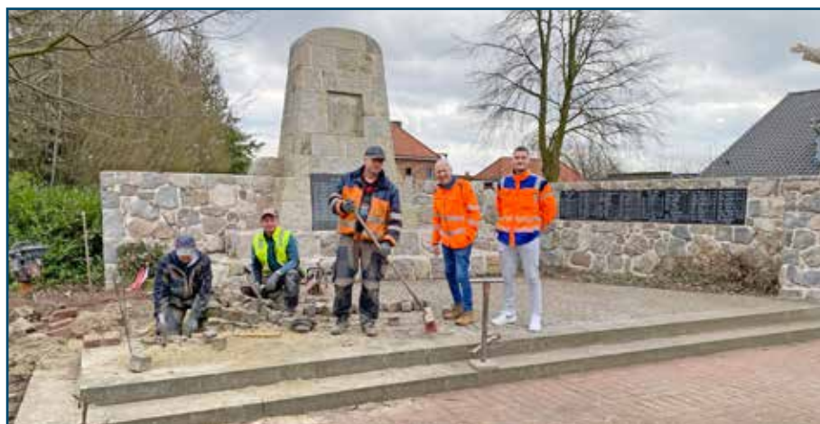
Fleißige Hände bei der Sanierung 2023
