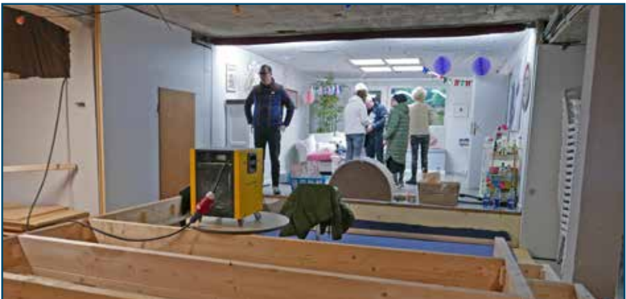
Viel Arbeit und Schweiß – Aufbau
